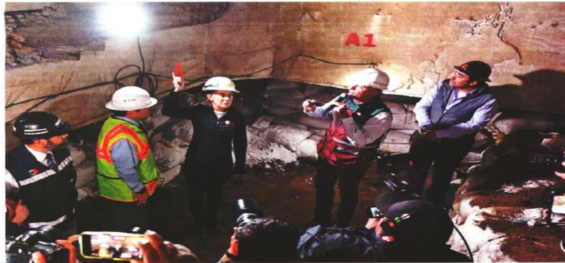
La jefa de Gobierno, Claudia Sheinbaum, y el secretario de Obras y Servicios, Jesús Esteva (segundo de der. a Izq.), supervisaron las obras en la Terminal 2.
