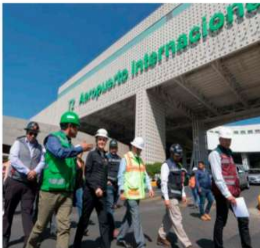
Supervisión de obras en la Terminal 2 del AICM.
