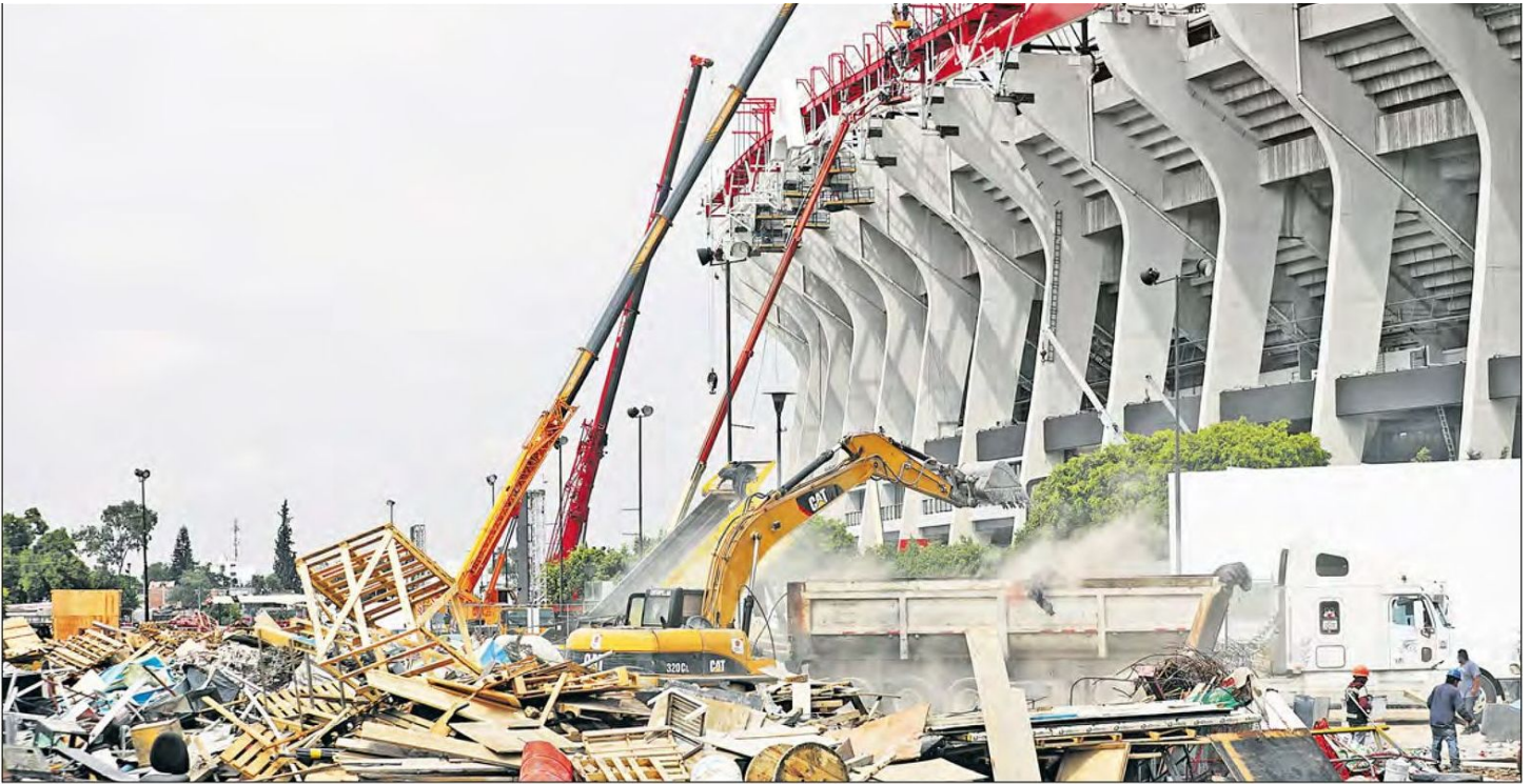
▲ A cuatro días de la reinauguración del estadio Azteca, ahora nombrado Banorte, se trabaja a marchas forzadas para terminar con los trabajos de remodelación. Foto Jair Cabrera
