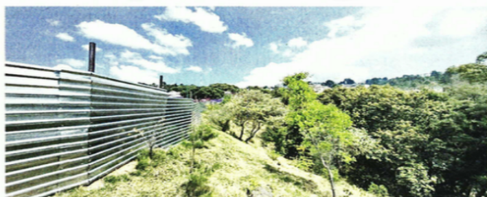
El paisaje natural de la Barranca contrasta con las obras que se llevan a cabo en el lugar.
