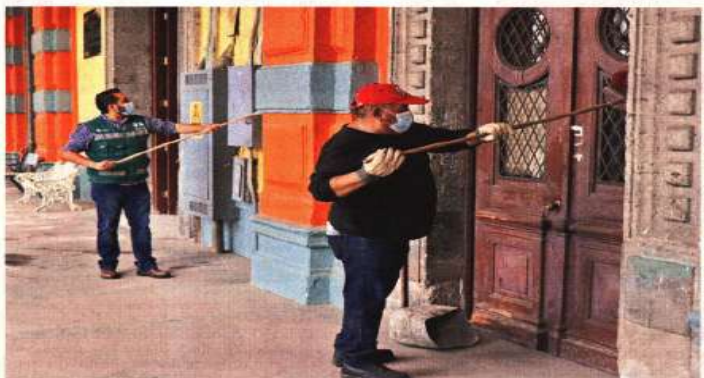
MANITA DE GATO. En la Escuela Secundaria Diurna N° 1 "César A. Ruiz" se realizan labores de remodelación.
