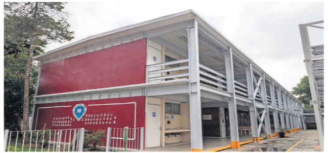
En la Escuela Primaria José de Jesús de la Rosa se reforzó la base de las columnas e instalaron contraventeos, un elemento estructural para aumentar la rigidez lateral de un edificio.
