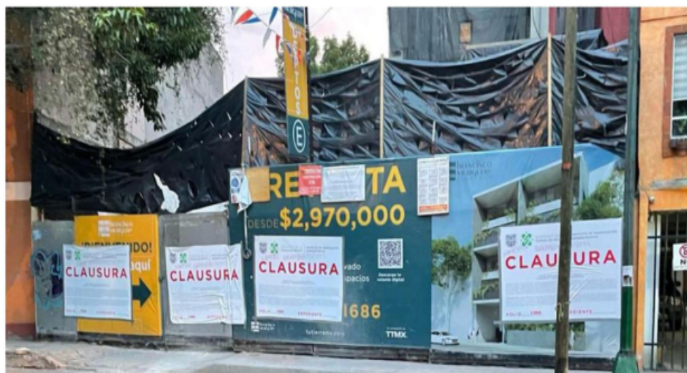
En la planta baja del número 86 hay humedad en los desplantes de muros, salitre, abultamientos y desprendimiento de pintura.
