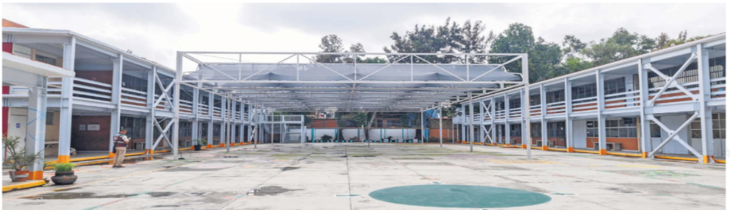
Después de cinco décadas de su construcción, esta primaria fue reforzada en la periferia con traveses que unieron columna con columna, explicó un funcionario.
