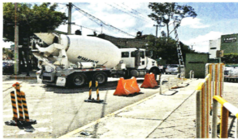
Dentro de la Cuarta Sección del Bosque se mantienen los trabajos; personal cultural fue destinado a tareas en el exterior.
