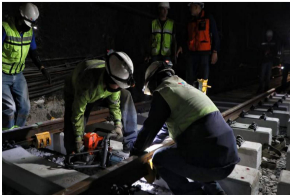
Trabajo a conciencia y de calidad se realizan en la Línea 1.
