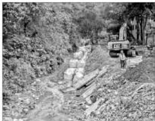
▲ Enormes costales con arena y grava contienen el potencial deslizamiento en la colonia El Piro. Foto Jair Cabrera Torres
