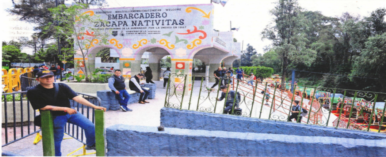
Como parte de las obras, se rehabilitaron las fachadas y se hizo un corredor turístico para unir los tres embarcaderos, indicaron autoridades capitalinas.
