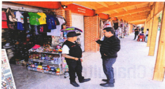
Durante la fase de rehabilitación se intervinieron 19 mil metros cuadrados para reconstruir y transformar 88 locales comerciales.
