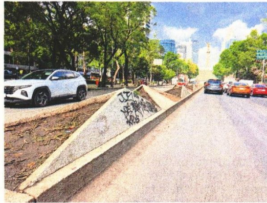
Las flores de cempasúchil colocadas en el camellón fueron destrozadas.
