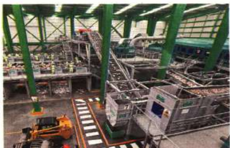
La nueva planta de tratamiento se localiza en Azcapotzalco.
