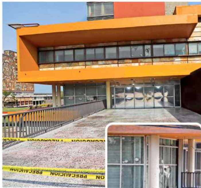
ASEDIO. Las puertas y ventanas de la Torre de Rectoría sufrieron daños, pero los manifestantes no pudieron forzarla la entrada.
