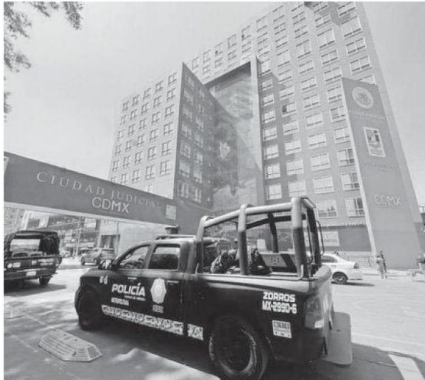
Elementos del agrupamiento antibombas llegaron a revisar edificios del TSJ
