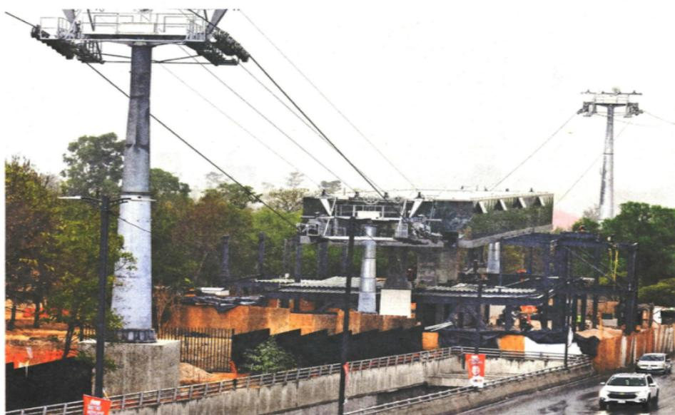
Se construyeron 40 torres a lo largo de los 5.5 kilómetros de trayecto de la Línea 3 del Cablebús.
