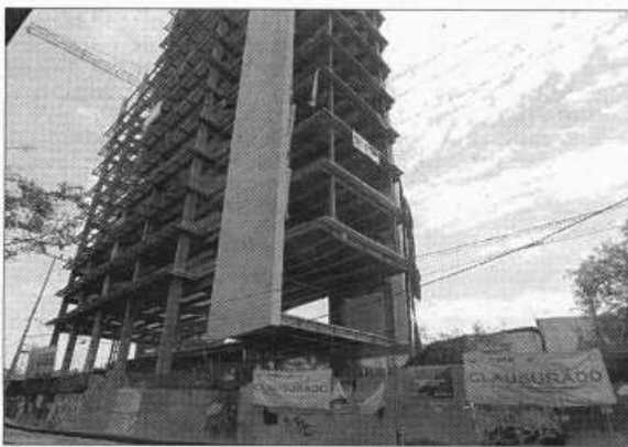
▲ El primero de enero de 2017 fue clausurada la construcción del edificio de 25 mil metros cuadrados, que alojaría oficinas corporativas, ubicada en Periférico Sur número 3042, en la zona de la presa Anzaldo. Foto Cristina Rodríguez
