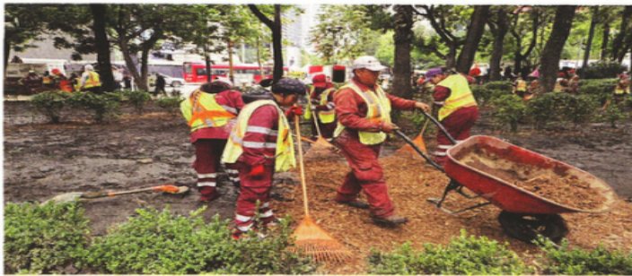
Con carretillas y rastrillos, brigadistas distribuyeron el mulch entre las jardineras dañadas.
