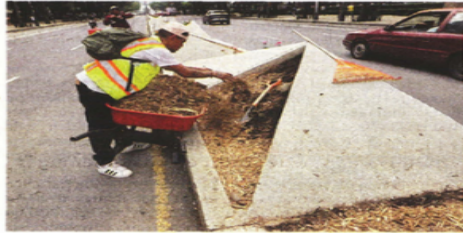
En el camellón, trabajadores esparcieron manualmente el material orgánico que humedecerá la tierra.
