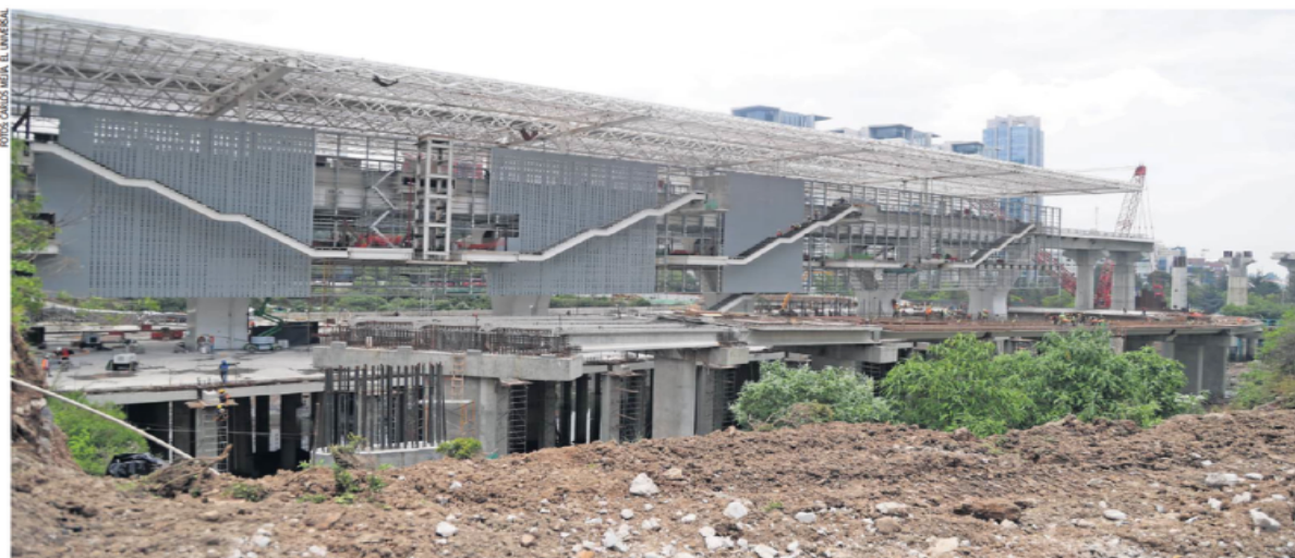
En el lugar se puede apreciar que la estación ya cuenta con escaleras eléctricas, techo, así como la presencia de casi un centenar de trabajadores que laboran en ella.
