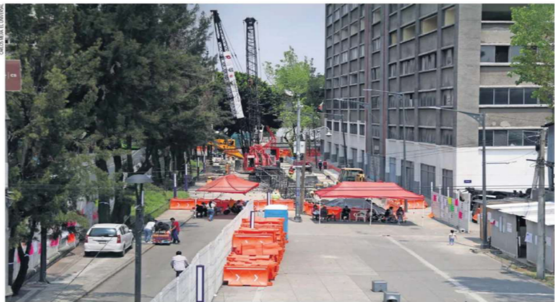
Personal de la Secretaría de Obras delimitó la zona de Fray Servando Teresa de Mier para colocar el hincado de pilotes.
