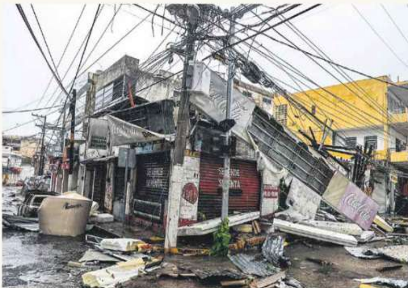
La peor parte. Todas las afectaciones están en Acapulco, donde se registraron las muertes y los daños materiales.
