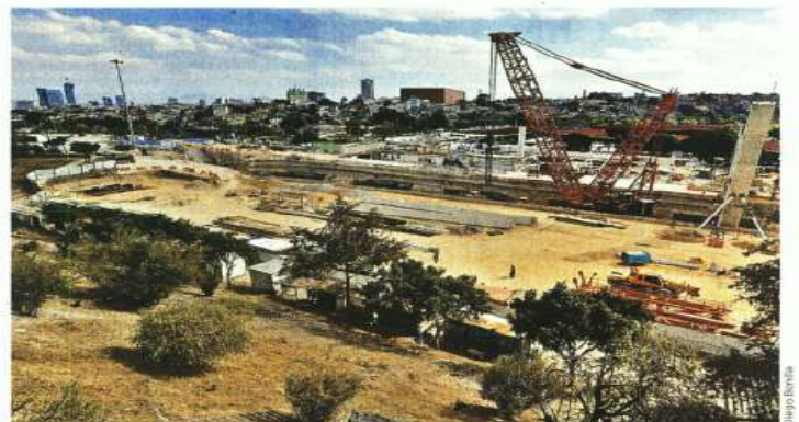
Con el trayecto a Santa Fe por concluirse, en el tramo a Observatorio se redobla el trabajo.
