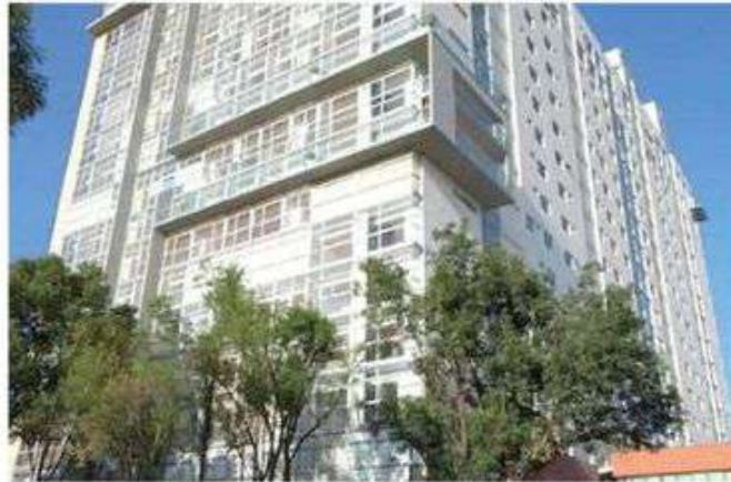
Construcciones que violan el reglamento para su edificación
