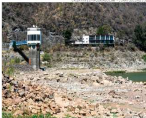
Así está la presa Miguel Alemán en Valle de Bravo, del Cutzamala.
