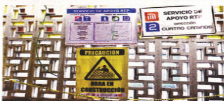
■ Sólo una lona y una cinta que delimita el espacio advierten a los usuarios del Metro de la realización de la obra.
