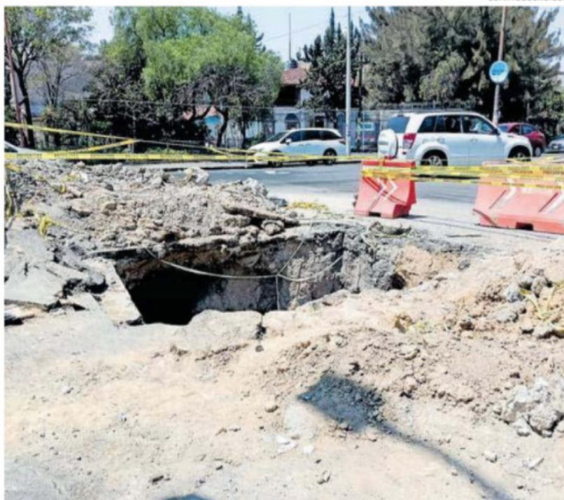
Obra inconclusa tras atenderse una fuga de agua en Avenida Santa Cruz Meyehualco y Plan de Ayala
