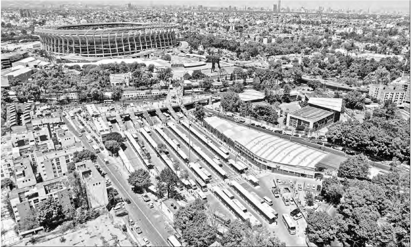
▲ El Cetrám Huipulco fue remodelado para privilegiar que los asistentes lleguen en transporte público a la zona, ya que de ahí deberán caminar hasta la entrada del inmueble. Foto La Jornada
