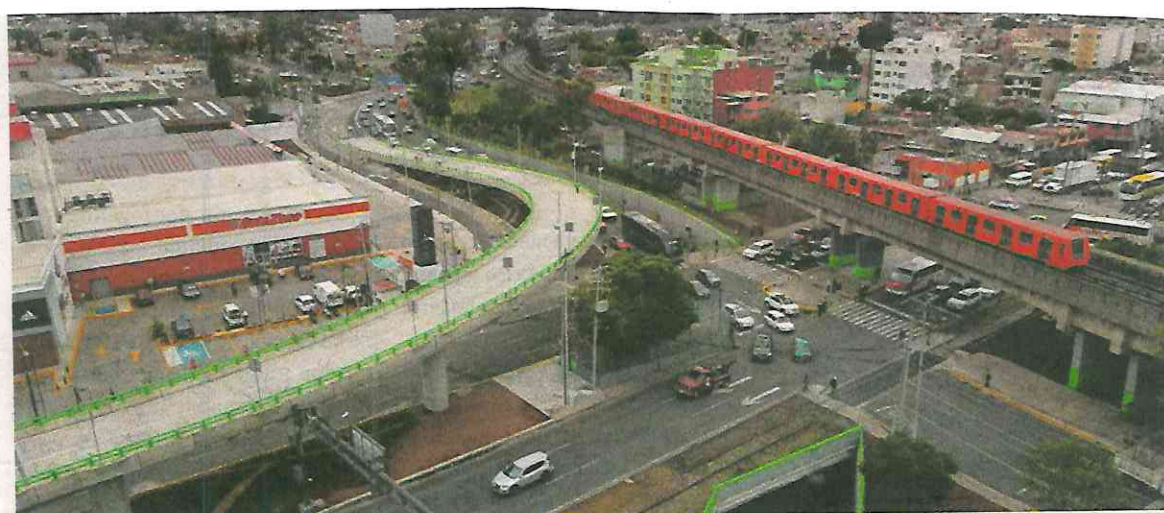
La obra incorpora el Viaducto Río de la Piedad con Calzada Ignacio Zaragoza.
