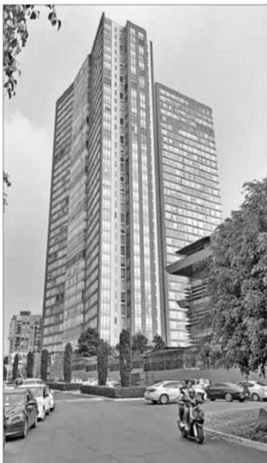
▲ La construcción de la segunda torre del complejo High Park Sur (derecha) concluyó recientemente y 50 departamentos ya están habitados, afirmó el abogado Rodrigo Muñoz. Foto José Antonio López
