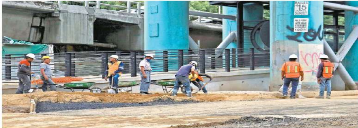
Personal de la Secretaría de Obras pavimenta los carriles exclusivos del Metrobús y afina los últimos detalles. Los trabajos registran un avance de 93%.
