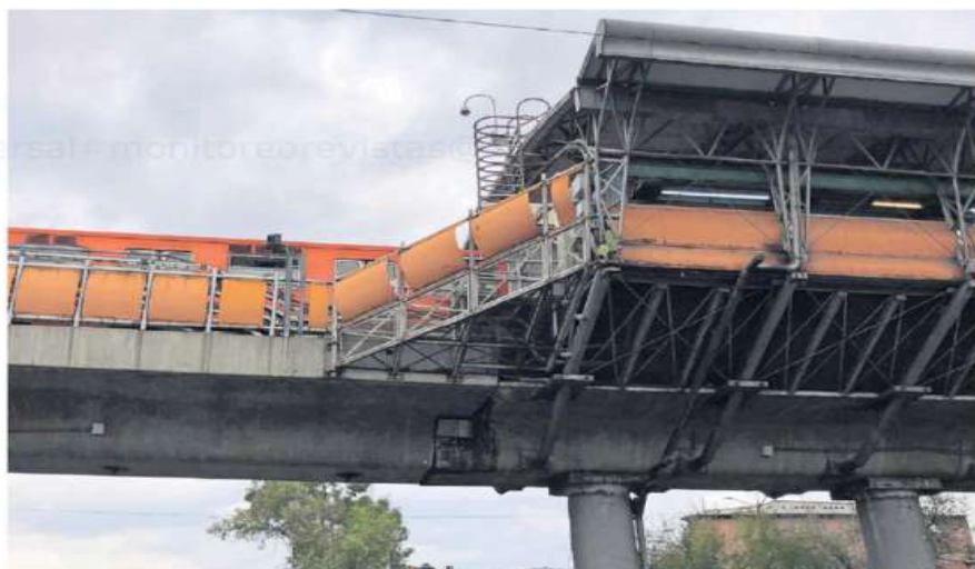
Con las obras en el tramo elevado de la Línea B del Metro se busca recuperar las condiciones originales que tenía hace 24 años. Los trabajos en las estaciones San Lázaro, Ricardo Flores Magón, Romero Rubio y Oceania se realizarán de las 0:00 a 5:00 horas.
