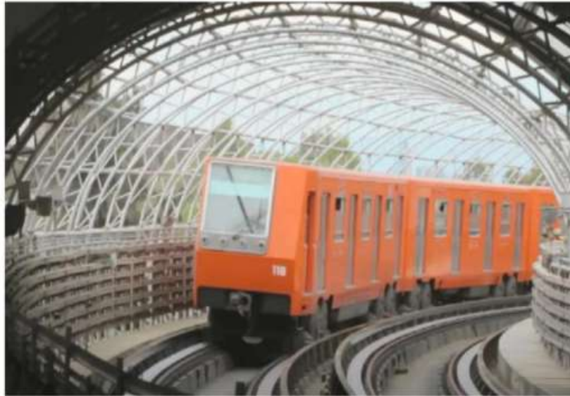
La Línea B no se va a cerrar para las obras, se trabajará por la noche.
