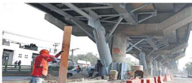
Mañana reabren seis estaciones del tramo metálico de la Línea 12 del Metro.
