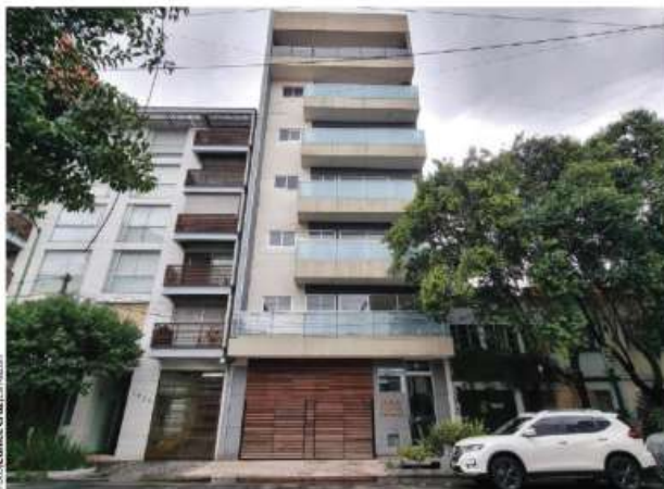
UNO DE LOS CONDOMINIOS irregulares, construido con tres pisos por encima de lo permitido, está en la calle Adolfo Prieto número 1038, en la colonia Del Valle Centro.
