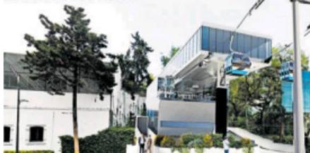
El Cablebús de la Línea 3 tendrá una velocidad de seis metros por segundo, 20 kilómetros por hora; total de cabina 180; pasajeros por cabina
