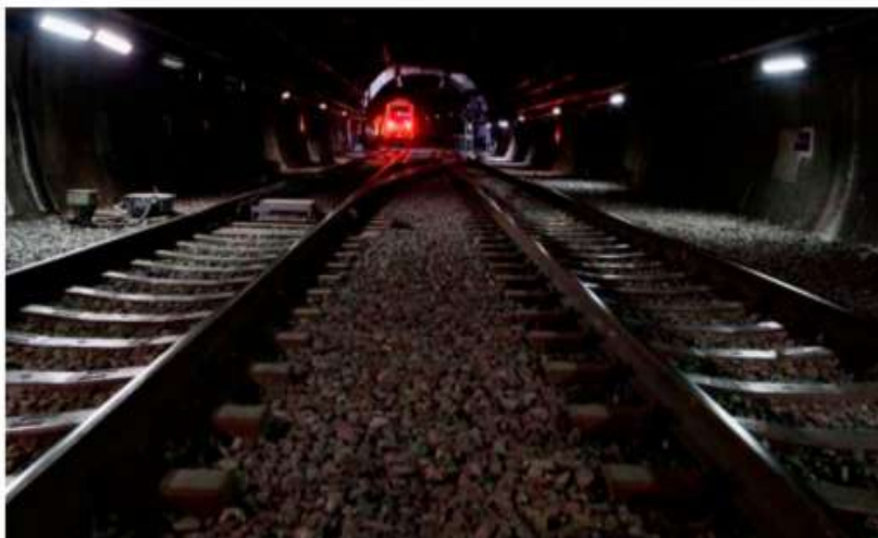
El Reforzamiento y rehabilitación del túnel de la Línea 12 concluyó en su totalidad: Guillermo Calderón.
