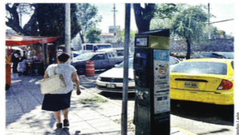
Algunos de los parquímetros instalados en Naucalpan quedaron en desuso con el paso del tiempo.
