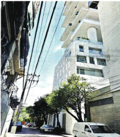
Los constructores de Torre Icon habilitaron una salida de emergencia irregular hacia Cerrada de Las Flores.
