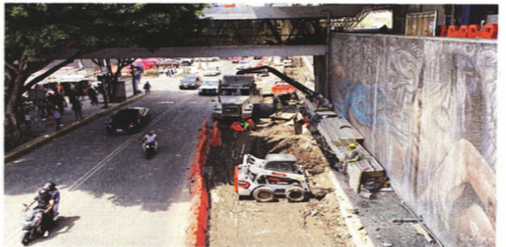
En Calzada de Talpan, aún se llevan a cabo trabajos para edificar el andador elevado.
