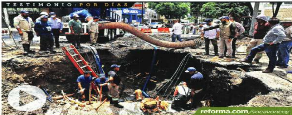
POCO A POCO. Ayer, brigadas de Sacmex continuaban con la reparación de la fuga ocurrida el domingo en Miramontes.
