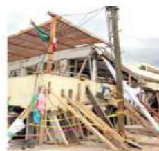
Foto: Archivo / Excelsior Aspectos del Rébsamen tras el colapso del 19-S.
