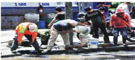
El agua que se desperdiciaba, en Canal de Miramontes, en el asfalto era recolectada por empleados de un autolavado.
