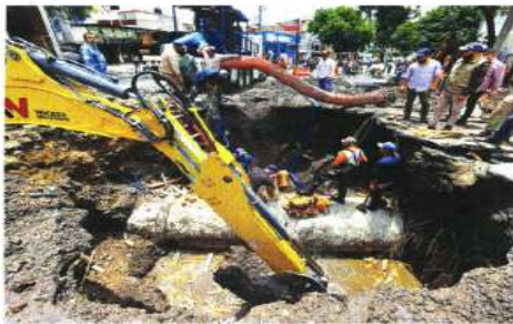
Personal de Sacmex y Protección Civil trabaja en la reparación del socavón que se abrió en Canal de Miramontes.
