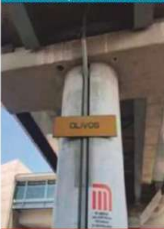
Tramo: Olivos-Nopalera Columna 7 Estación
