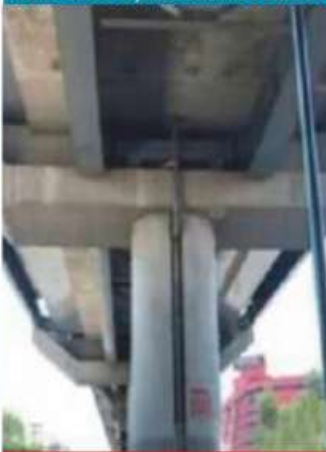
Tramo: Olivos-Nopalera Columna 8 Estación
