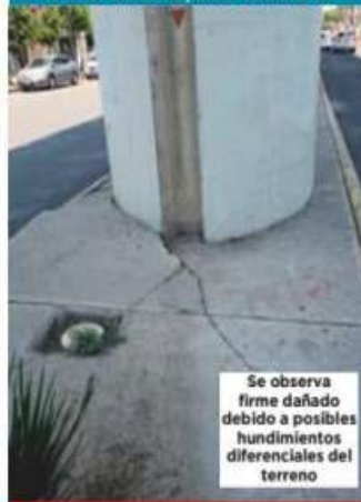
Tramo: Olivos-Nopalera Columna 46
