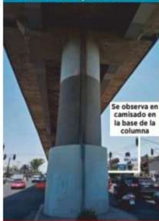
Tramo: Olivos-Nopalera Columna 31
