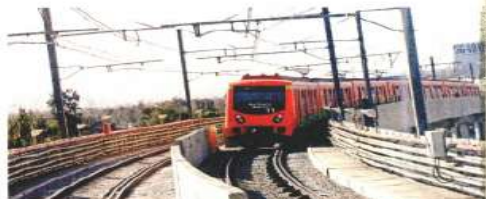
La compañía DB Engineering & Consulting GmbH argumentó que sólo asesoró en sistemas eléctricos de la Línea 12.
