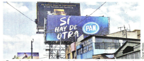
■ Organizaciones temen que el plazo para el retiro de anuncios sobre azotea no sea cumplido.
