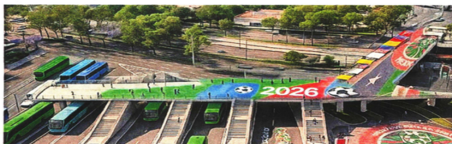
Visualización de los alrededores del Estadio Banorte con los trabajos de rehabilitación en Huipulco.
