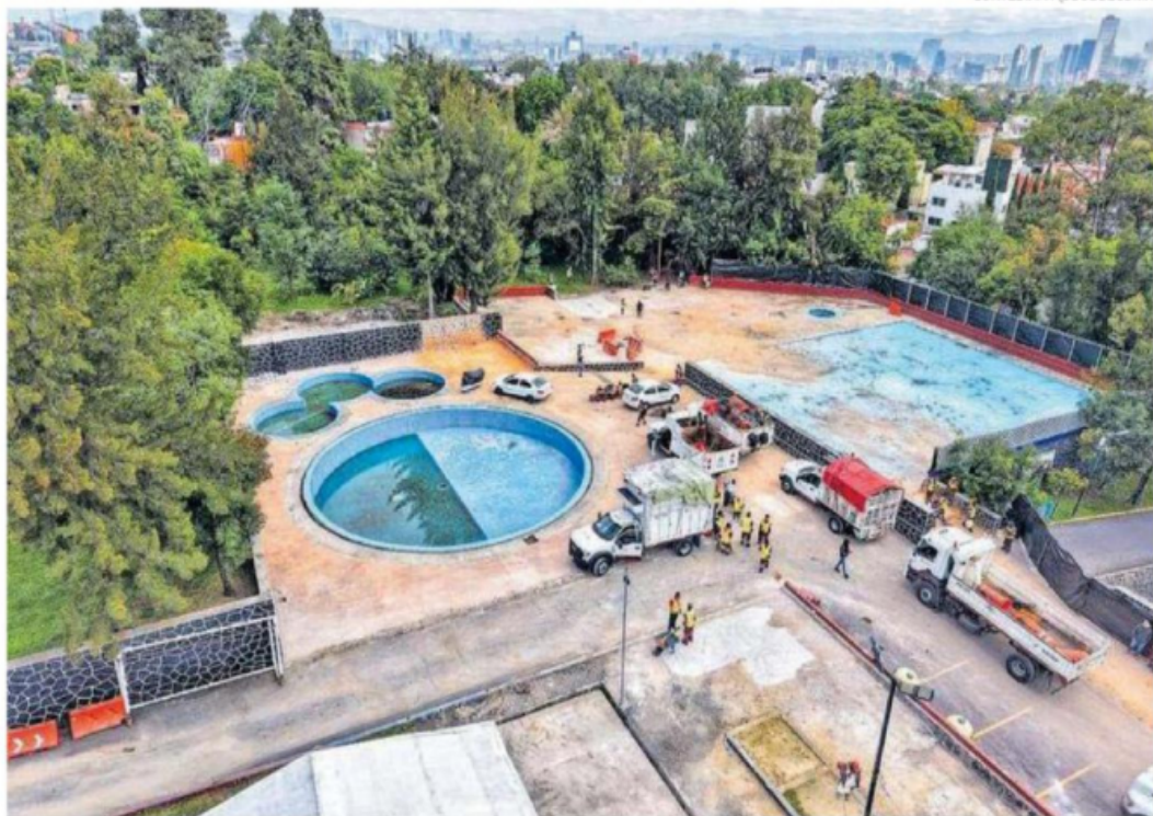
Obras de la Utopía Parque Japón en Álvaro Obregón, uno de los proyectos que este año inició el gobierno de la CdMx
