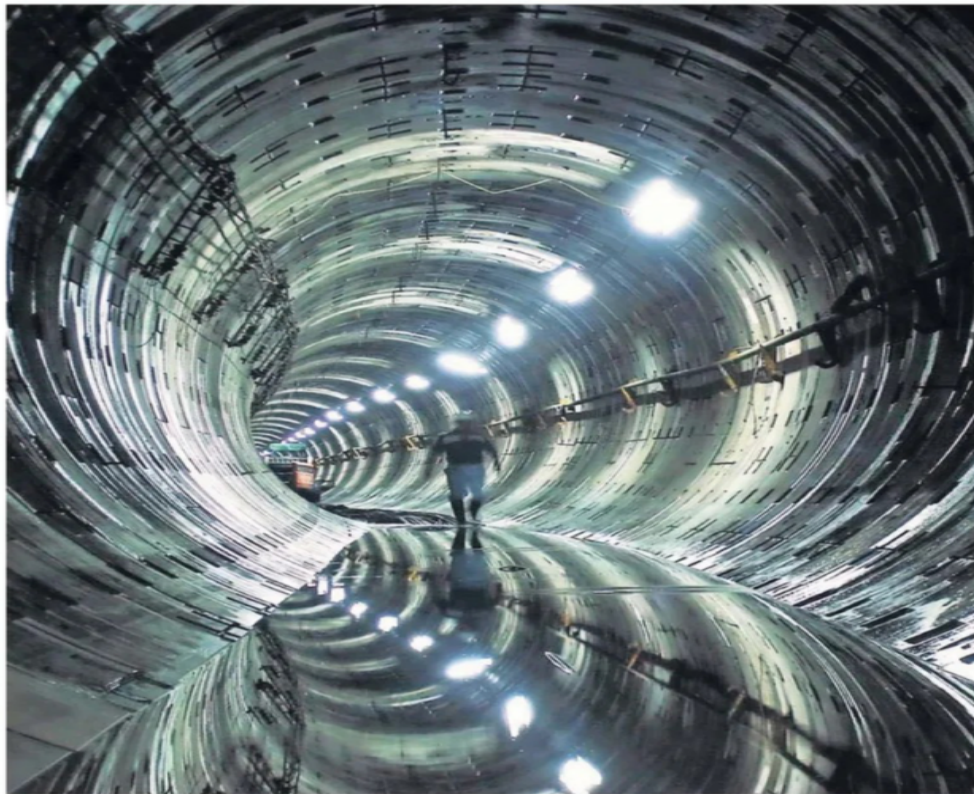
El sistema de drenaje fue inaugurado en junio de 1975 y alcanza una profundidad de hasta 200 metros. Su construcción se pensó para atender la demanda de 10 millones de habitantes, pero actualmente es el doble.
