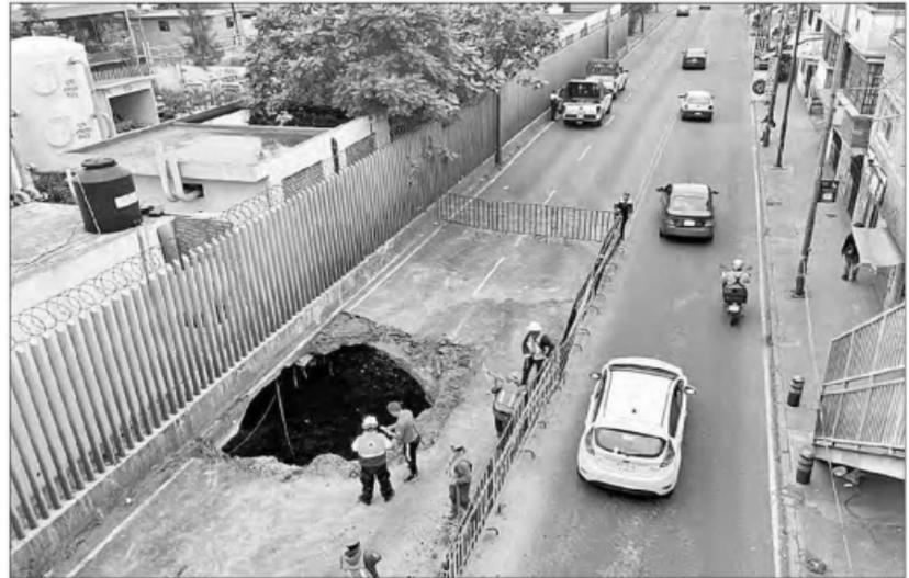
► La hendidura sobre Canal de Garay mide unos tres metros de diámetro, y se extiende unos dos metros bajo las instalaciones de una planta potabilizadora, sin dañarlas. Fotos Ángel Bolaños
